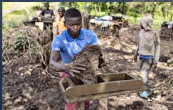
Landsbyens store drenge laver mursten af lerjord til at bygge huse af. Stenene skal bagefter tørres og brændes.
